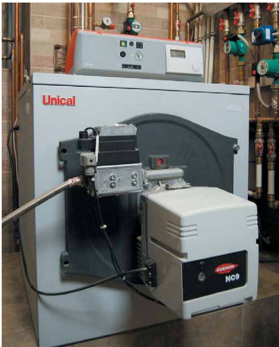
Котельная на базе котла RECAL.
