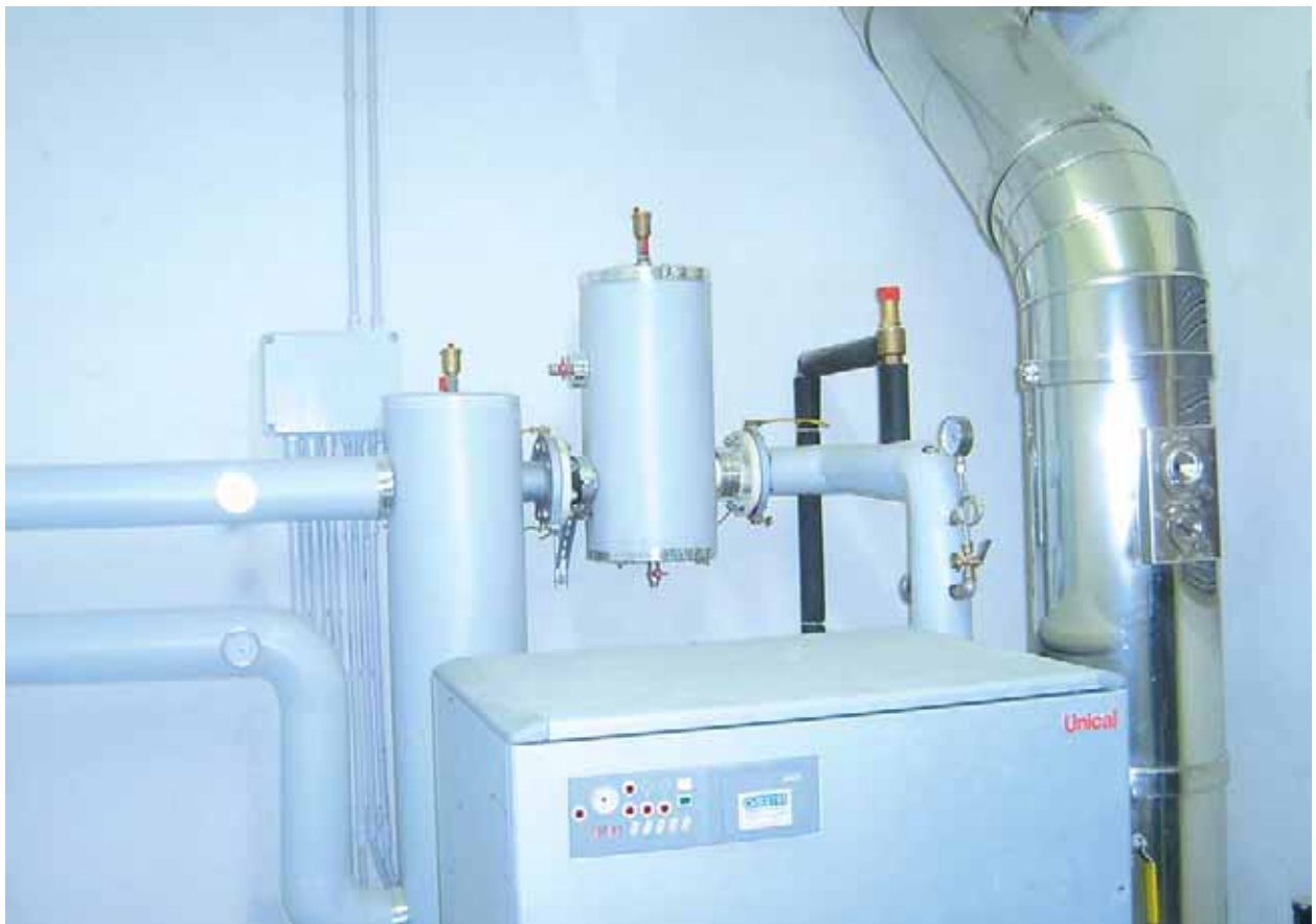
Котельная на базе котла MODULEX
