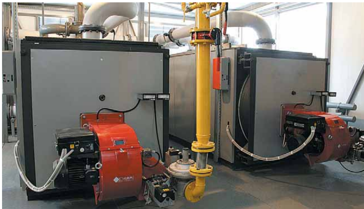
Котельная из котлов ELLPREX.
