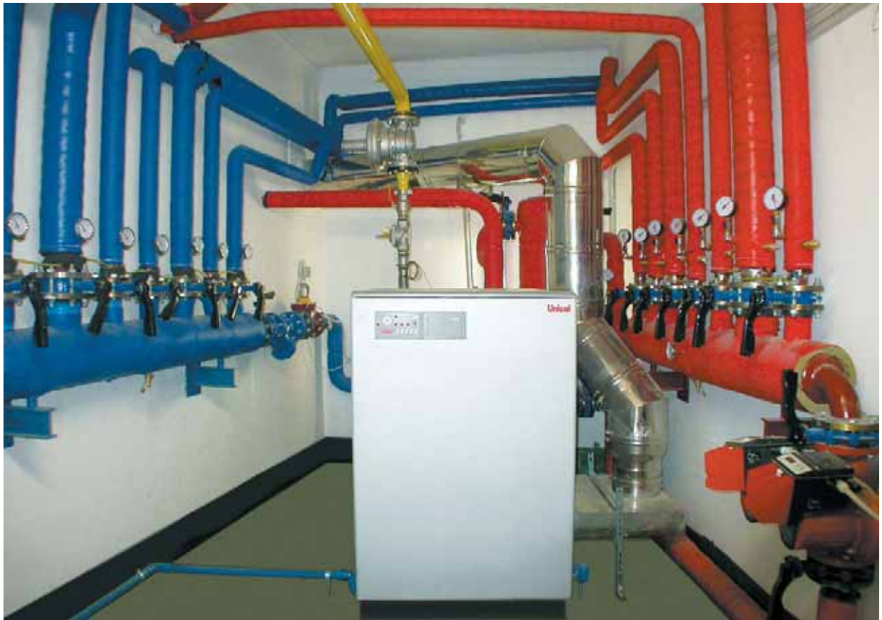
Котельная на базе котла MODULEX
